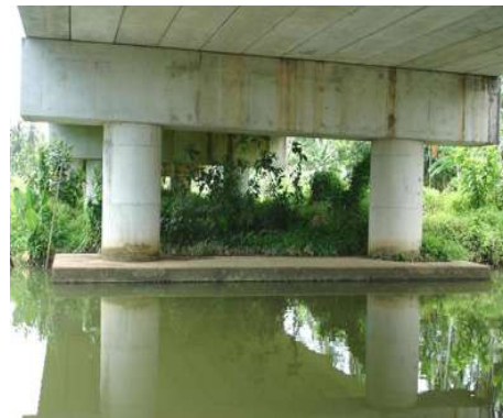
รูปที่ 3.1-4 Pier Column เสากลมคู่สภาพดี
