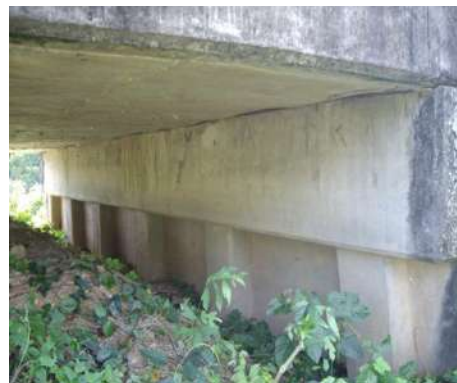
รูปที่ 6.3-6 ลาดดินคอสะพาน ถูกขูดระดับใกล้ชายผนังกันดิน
