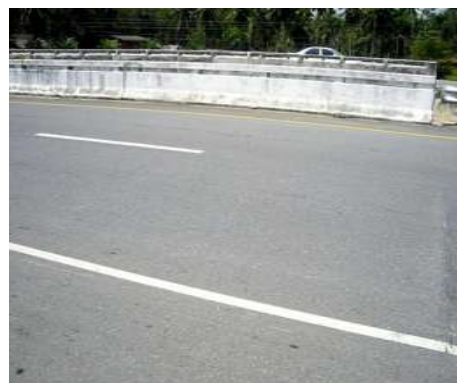
รูปที่ 1.2-14 ผิวลาดยาง ภายหลังเปิดใช้งานแล้ว
