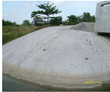
รูปที่ 6.1-2 ผิวคอนกรีตใหม่
