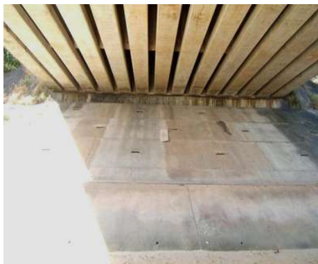
รูปที่ 2.1-9 I - GIRDER SPAN 50 m. สภาพดี
