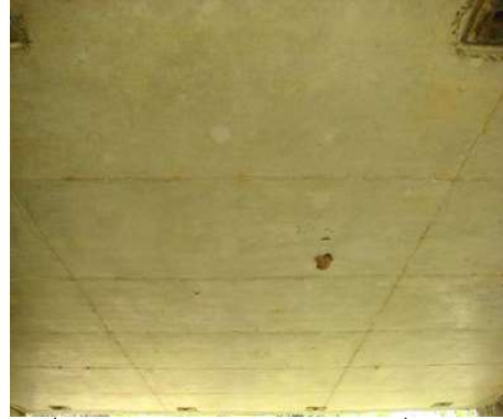
รูปที่ 2.1-2 SLAB TYPE สภาพดี เริ่มมีจุดผิวกอนกรีตเปลี่ยนสีและคราบดิน
