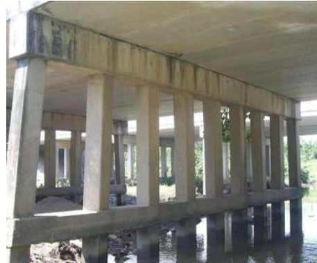
รูปที่ 3.1-2 Pile Bent มีคาน Bracing สภาพดีใหม่
