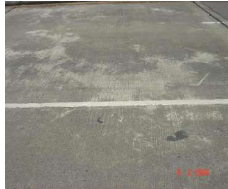
รูปที่ 1.1-6 สภาพดีค่อนข้างเก่า ผิวมีคราบสีดำ
