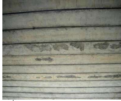
รูปที่ 2.1-6 BOX GIRDER สภาพดี
