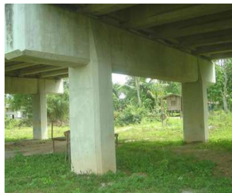
รูปที่ 3.1-6 Frame Column เสาคู่สภาพดี
