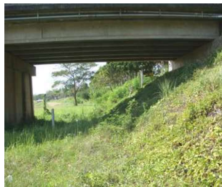
รูปที่ 6.1-4 ลาดดิน สภาพดี ปลุกต้นไม้
