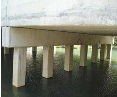
รูปที่ 3.1-1 Pile Bent สภาพดีใหม่
