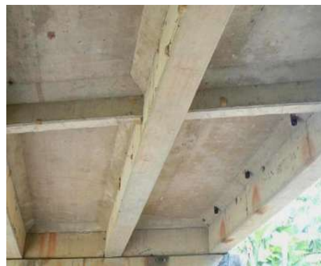
รูปที่ 2.1-10 T - GIRDER สภาพดี
