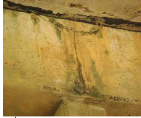
รูปที่ 3.2-8 ปาดานหัวเสาหัวและมอดระบายน้ำ
