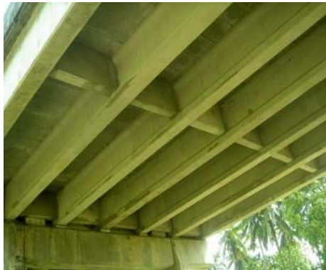
รูปที่ 2.1-7 I - GIRDER สภาพใหม่
