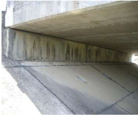
รูปที่ 6.1-1 ผิวคอนกรีตใหม่
