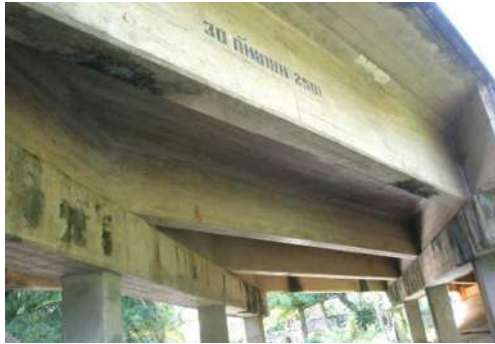
รูปที่ 2.2-13 T - GIRDER (TG.)
