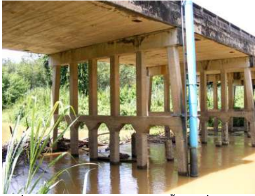
รูปที่ 4.1-9 สภาพด้านล่างสะพานน้ำไหลเชี่ยวและมีสิ่งลอยน้ำ
