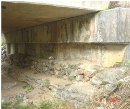
รูปที่ 6.2-3 หินเรียงยาแนว ก่อสร้างระดับ ความสูงใกล้เคียงกันดิน
