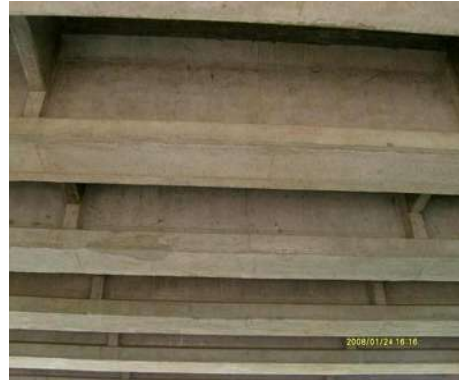
รูปที่ 2.1-8 I - GIRDER สภาพดี
