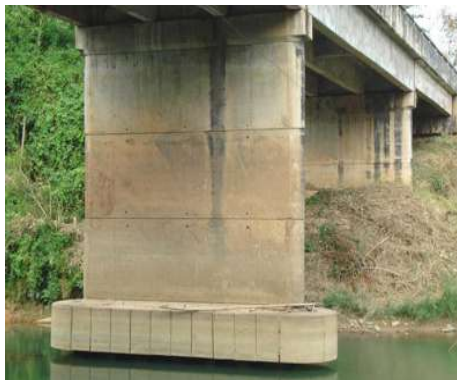
รูปที่ 3.1-3 Wall Pier สภาพดี
