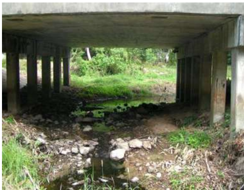
รูปที่ 4.1-7 สภาพลำน้ำและโครงสร้างด้านล่าง
