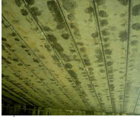
รูปที่ 2.1-5 MULTI BEAM สภาพดี
