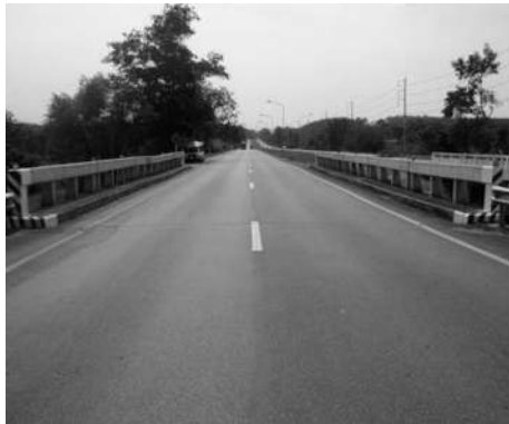
รูปที่ 4.1 สะพานทรุดด้านซ้าย ดับที่ 4 และขวา ดับที่ 2
