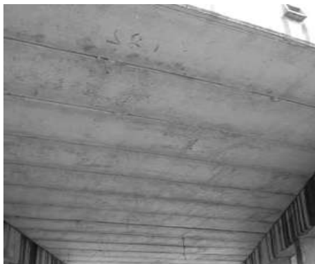
รูปที่ 2.1-3 PLANK GIRDER สภาพใหม่
