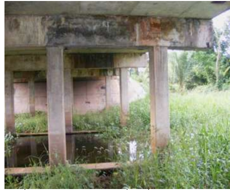
รูปที่ 4.8 รูป ตอม่อ ตับที่ 4 ที่ทาดเฉียง ( รูปย้อนกลับ) ผิวซ่อมที่คานหัวเสา
