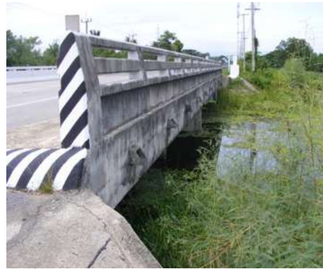
รูปที่ 5.1-6 ทางเท้า สภาพดี
