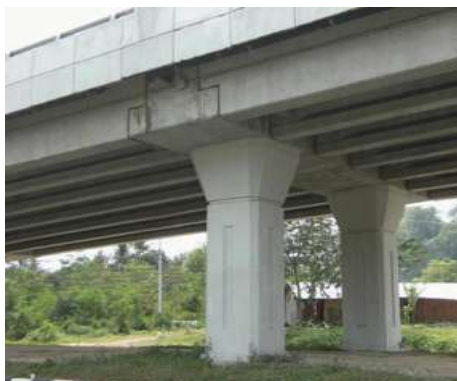
รูปที่ 3.1-5 Pier Column เสาคู่สภาพดี
