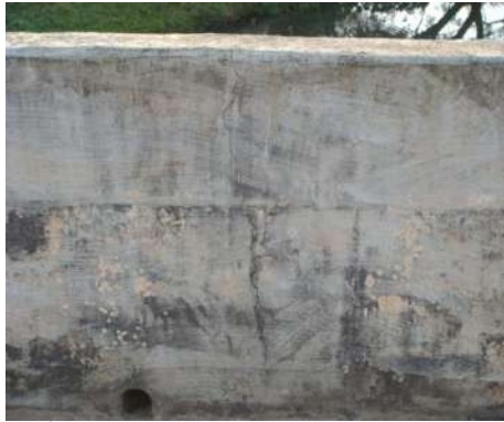
รูปที่ 5.2-3 ราว BARRIER รั้วขวาง
