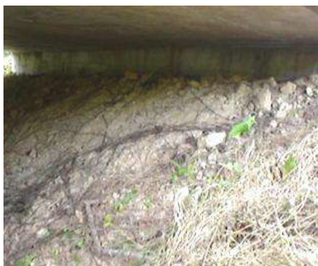
รูปที่ 6.1-5 ลาดดิน สภาพดี
